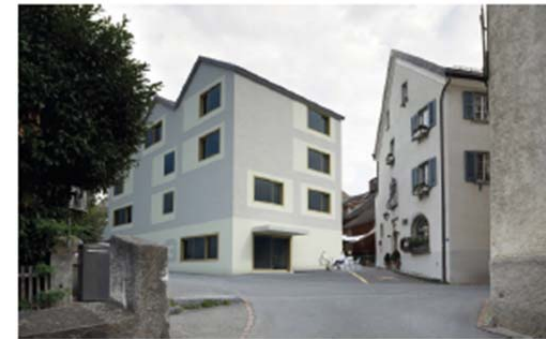
(Abb: Wohnbauprojekt Fläsch «WohnenPlus»)
