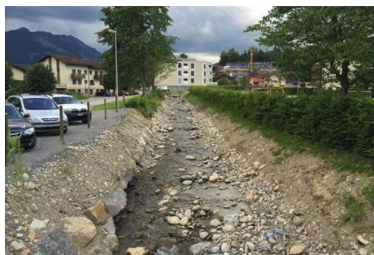
Abb. 123: Sanierter Manebach, Höhe Schwimmbad
