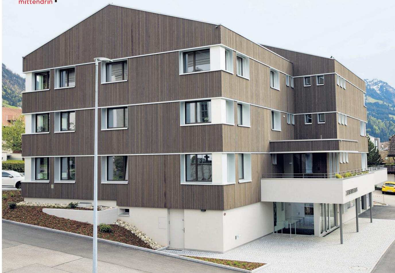
Die neue Holzfassade besteht aus einheimischer druckimprägnierter Weisstanne. [Bilder Bruno Rööfli]
