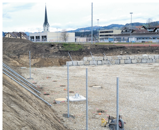
Baustelle Kunstrasenfeld: Die Arbeiten laufen nach Plan.
